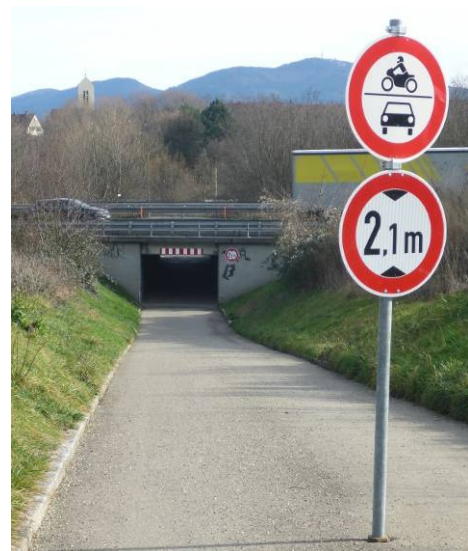
Foto 2: Unterführung 2 gesperrt für Kraftfahrzeuge.
