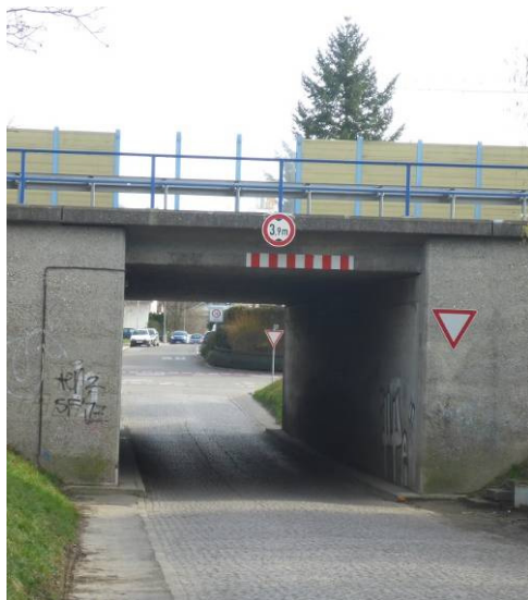
Foto 1: Unterführung 1 mit Kraftfahrzeugverkehr
