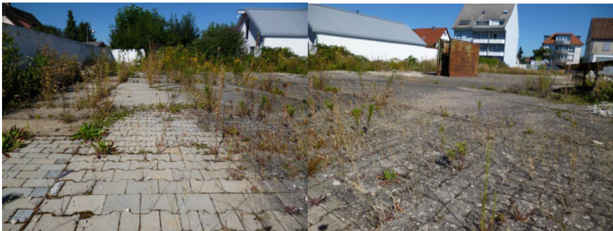
Foto 3 und 4: Gepflasterte Bereiche mit Vegetation in den Fugen (F1)
