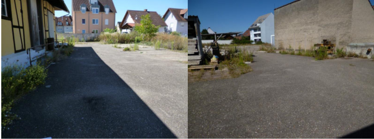
Foto 1 und 2: Asphaltierte Bereiche (F1)
