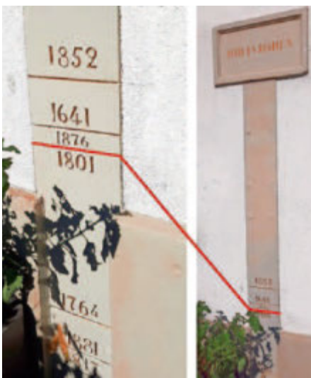
Abb. 1: Ausschnitt und Gesamtansicht von Hochwassermarken an einem Gebäude in der Oberen Rheingasse in Basel. Durch die rote Linie ist der Hochwasserstand vom 18. Juni 1876 hervorgehoben. Über diesen Wasserstand können die maximalen mittelalterlichen Wasserstände im Bereich von Neuenburg am Rhein abgeschätzt werden.
