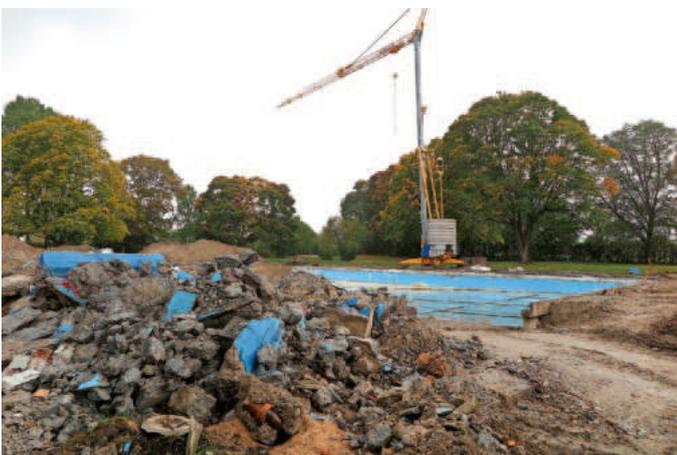
Das alte Becken ist ausgeräumt und wird jetzt vergrößert. Später wird es mit einer Folie ausgekleidet.
