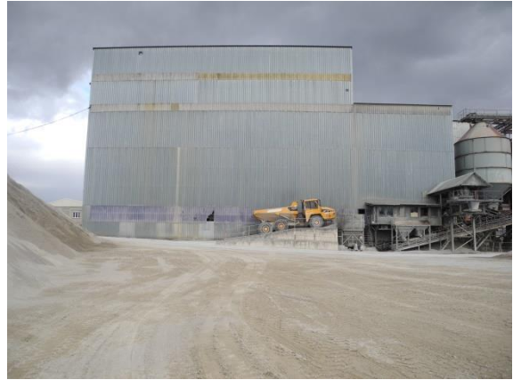
Blick auf das südlichste Gebäude in Raumeinheit 8 von Süden
