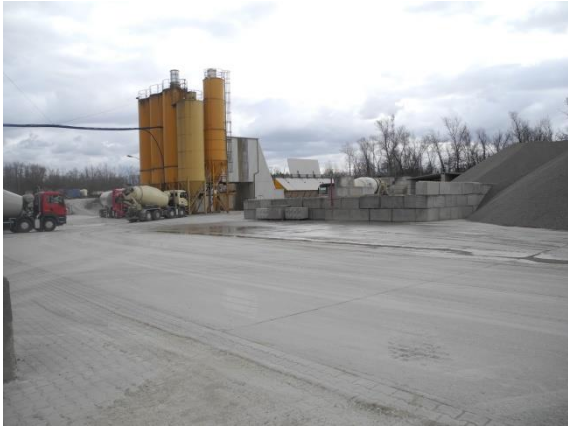
Blick auf Raumeinheit 13 von Nordwesten
