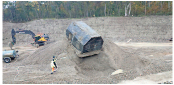
Auch ein Weltkriegsbunker, der unter Denkmalschutz steht, wurde im Rahmen der Arbeiten zum Hochwasserschutz tiefer gelegt.
