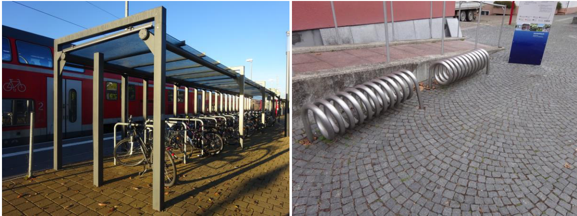
Abbildung 16: Attraktive Radabstellanlage am Bahnhof Neuenburg (links); Unattraktive 'Felgenfresser' am Rathaus Neuenburg (rechts).
