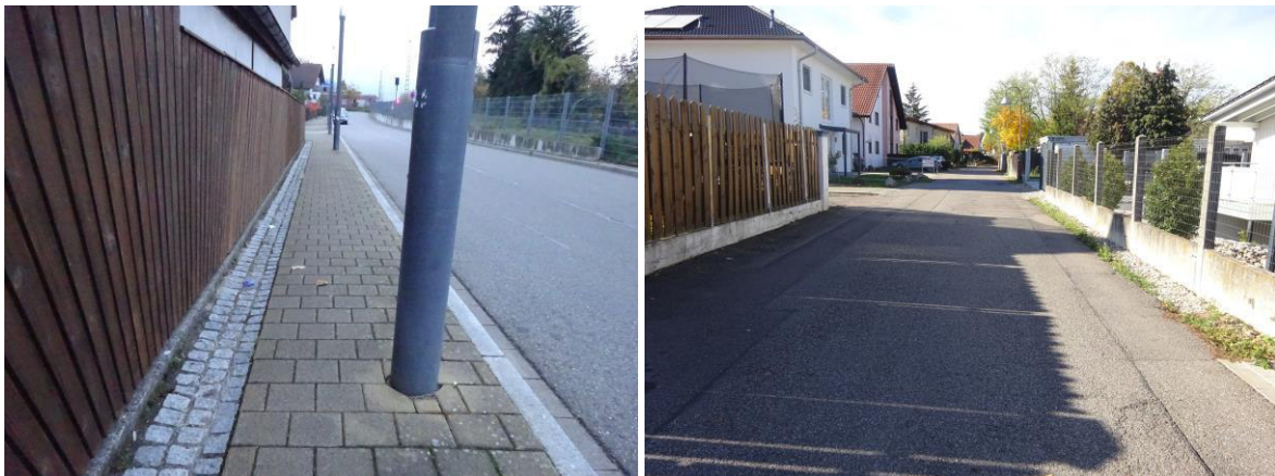
Abbildung 3: Geringe Gehwegbreite an der Straße Beim Bahnhof (links); Fehlende Infrastruktur für Zufußgehende in der Tullastraße (rechts).
