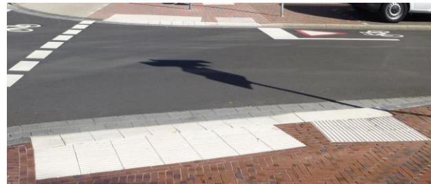
Abbildung 20: Beispielbild: Prinzip der Doppelquerung (Nullabsenkung zzgl. Kante) Quelle: eigenes Bild
