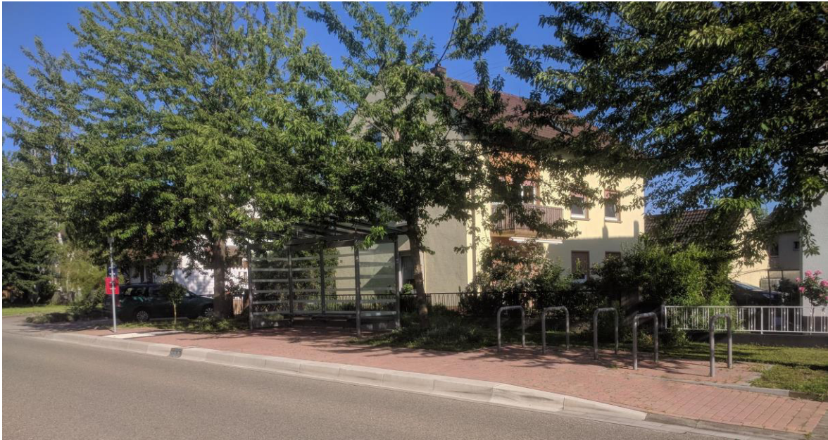
Abbildung 33: Ausbau einer barrierefreien Bushaltestelle mit Anlehnhaltern
