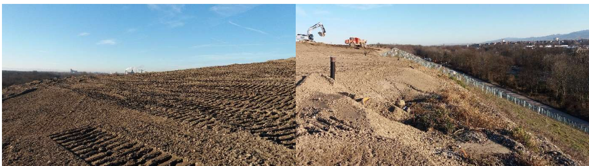
Foto 1 und 2: Blick auf die Deponieoberfläche und von dort nach Nordosten auf die ostexponierte Flanke, an der im Hintergrund die Aufforstung zu erkennen ist.
