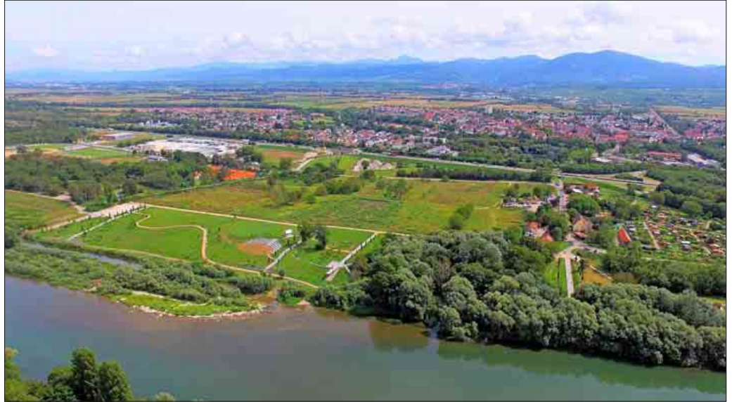
Blick auf das künftige LGS-Gelände. In der Bildmitte ist die Baustelle für die Erweiterung der Autobahnunterführung zu sehen. Foto: Drohnenflug Maria Zipfel
