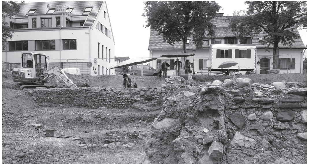
Noch haben die Archäologen das Sagen: Grabungsarbeiten in der Neuenburger Schlüsselstraße
