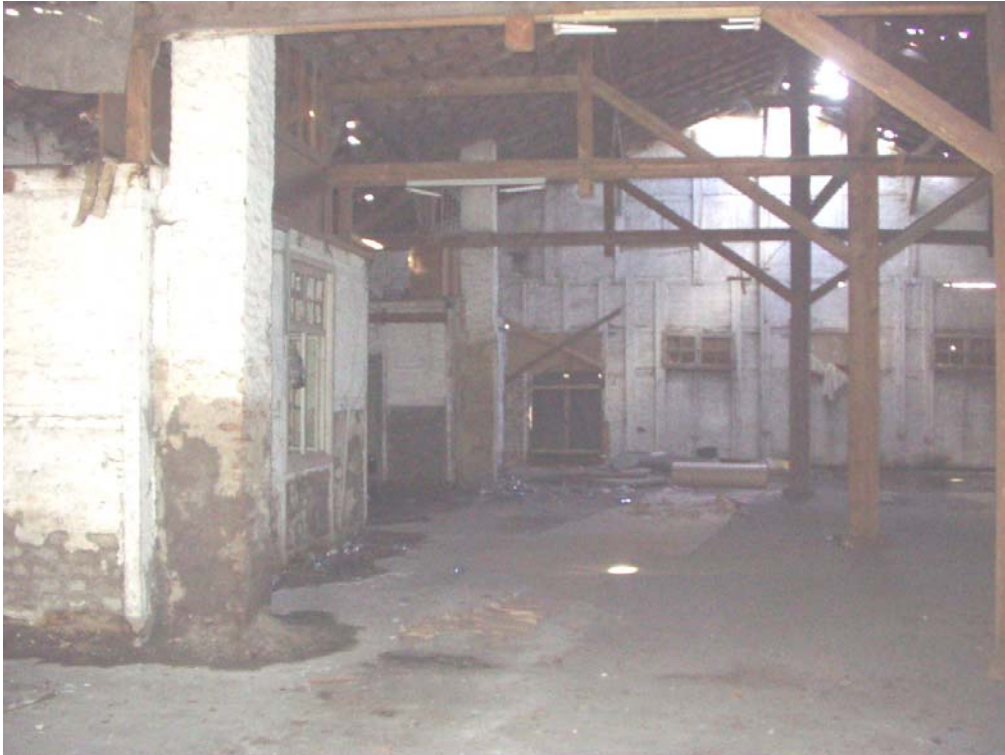
Innenansicht der Güterhalle (Blick nach Westen)
