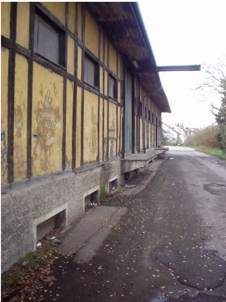
Außenansicht der Güterhalle (Nordseite)
