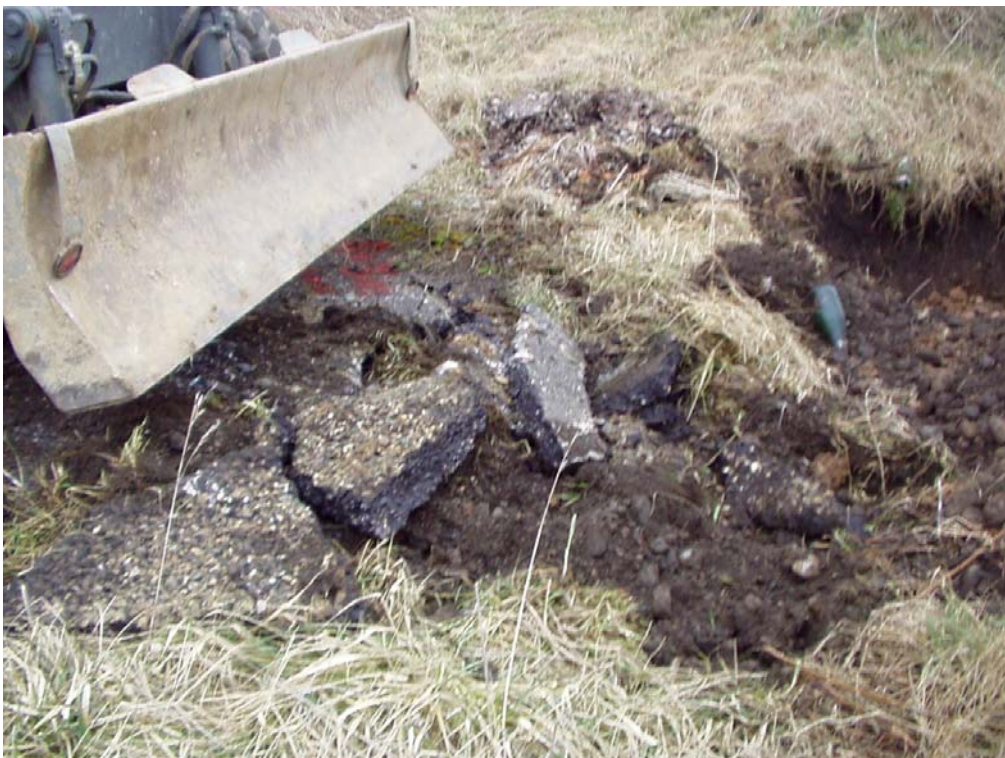
Asphalt und Unterbau bei Schurf 2 (Parkplatz am Klemmbach)
