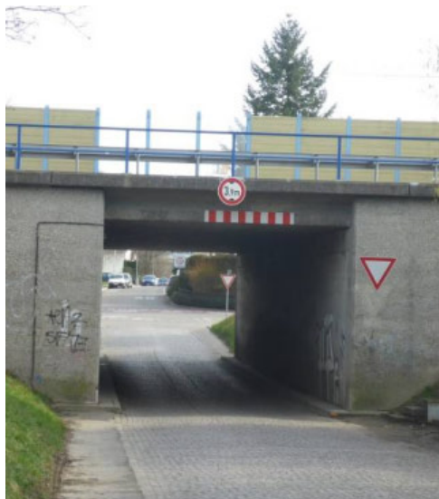
Foto 1: Unterführung 1 mit Kraftfahrzeugverkehr
