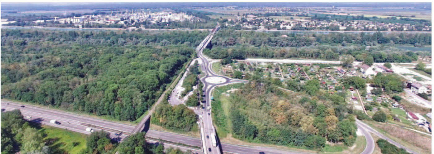
Blick über die Autobahn A5 und den westlichen Kreisverkehr, neben dem die Kleingartenanlage zu sehen ist. Am oberen Bildrand erkennt man den Rhein als Grenzfluss und dahinter den französischen Ort Chalampé sowie dessen Industrieanlage.
