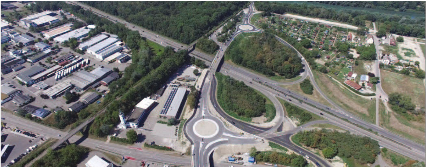
Im Vordergrund der neu gestaltete östliche Kreisverkehr der Anschlussstelle A5. Von dort führt die Straße über die Autobahn zum westlichen Kreisverkehr, neben dem die Kleingartenanlage und die Baustelle der Landesgartenschau erkennbar sind. Am oberen Bildrand befinden sich der Altrhein sowie der Rheinkanal, dahinter die französische Nachbargemeinde Chalampé.
