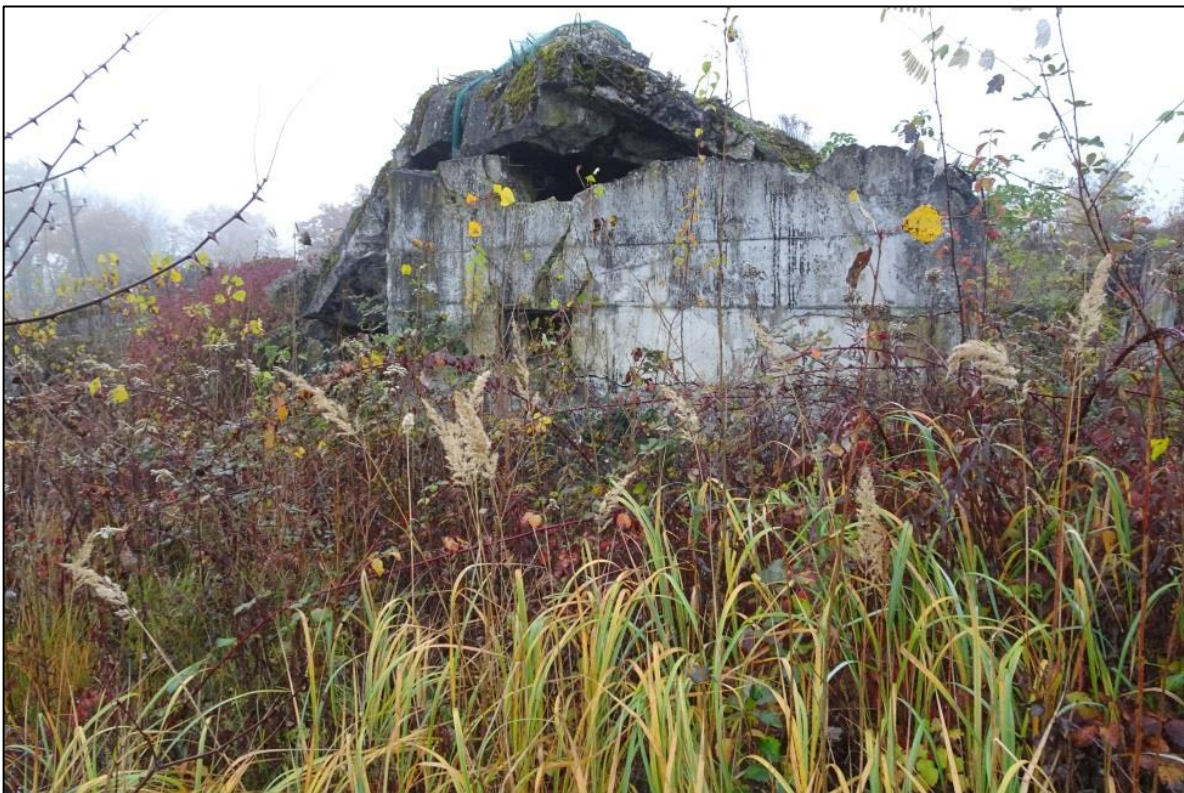
Abb. 5: Im westlichen Teil des Planungsgebiets befindet sich ein gesprengter Bunker, der in seinem aktuellen Umfang erhalten werden soll.
