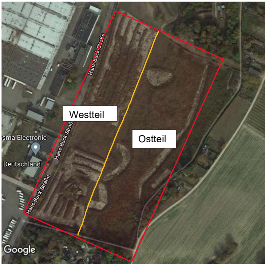
Abb. 1: Luftbild (Google) des Untersuchungsgebietes des Flurstücks Nr. 4560/3, deutlich erkennbar sind hell offene, vegetationsarme Kiesfelder sowie in diesen oder direkt benachbart in linearer Form erkennbar Erdwälle, die von unterschiedlich dichter Vegetation eingenommen sind.
