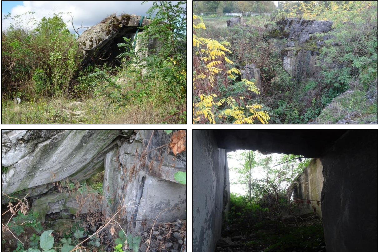
Abb. 6: Weitere Ansichten des größtenteils überwachsenen Bunkers im westlichen Teil des Planungsgebiets.
