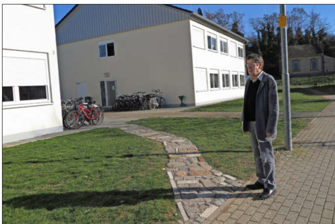
August Walz vom Helferkreis freut sich über den neuen Zugangsweg zur Gemeinschaftsunterkunft, den die Geflüchteten in Eigenleistung gebaut haben.
