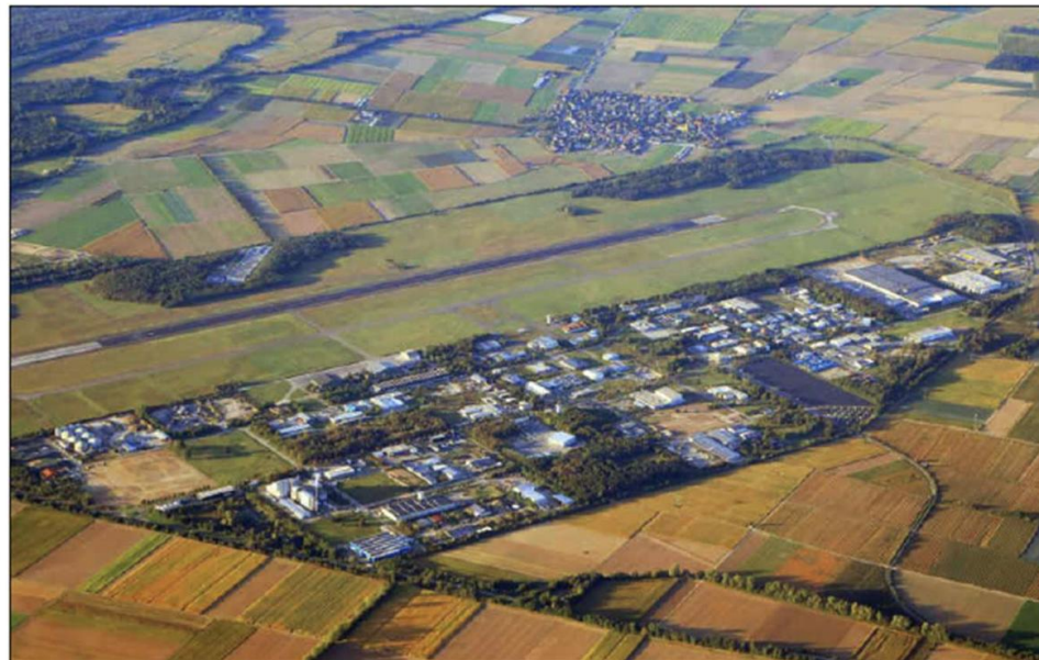
Soll Standort einer Landeserstaufnahme werden: der Gewerbepark Breisgau in Eschbach (hier im April 2023)
