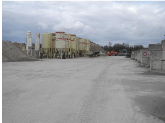
Blick in Raumeinheit 2 von Norden
