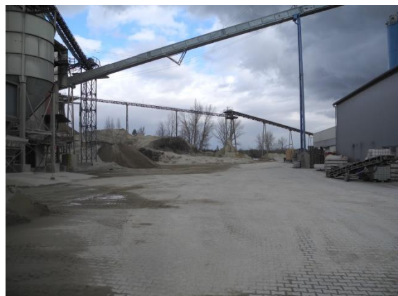
Blick in Raumeinheit 6 von Süden; im Hintergrund Raumeinheit 7
