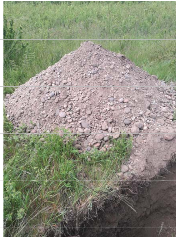
Aushub Flusskies (Homogenbereich B2)
