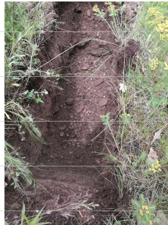
Schurf SCH 8, Kies direkt unter dem Oberboden
