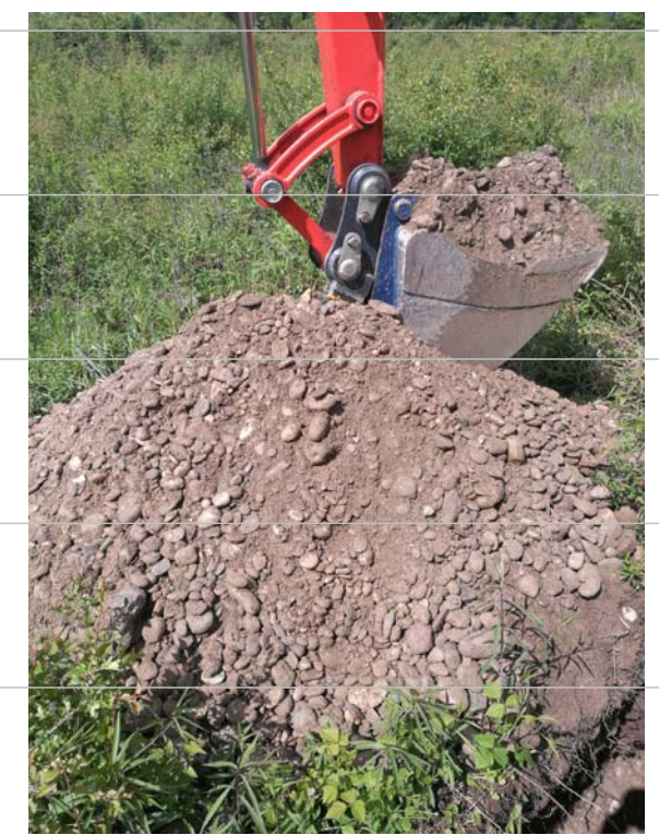
Aushub Flusskies (Homogenbereich B2)
