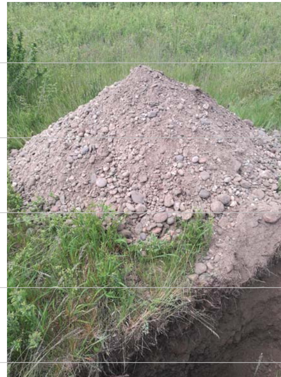
Aushub Flusskies (Homogenbereich B2)
