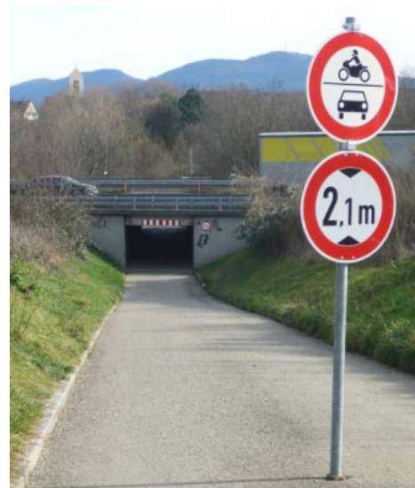
Foto 2: Unterführung 2 gesperrt für Kraftfahrzeuge.
