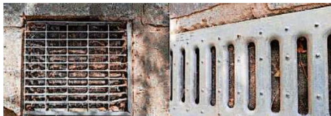
Foto: Ablauf vor Kellereingang und Ablaufrinne
