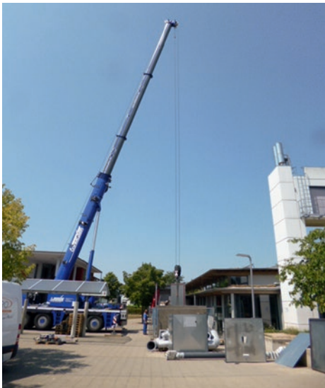
Anlieferung von Einzelteilen für die Hackschnitzelanlage am Schulzentrum
