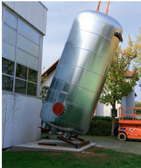
Der Pufferspeicher der Hackschnitzelanlage umfasst 30.000 Liter
